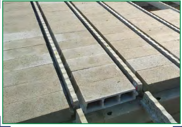
PLANCHER POUTRELLES / HOURDIS
