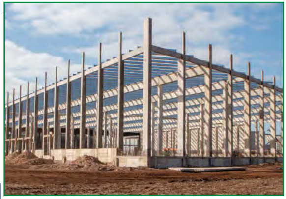
CHARPENTE EN BÉTON PRÉFABRIQUÉ
